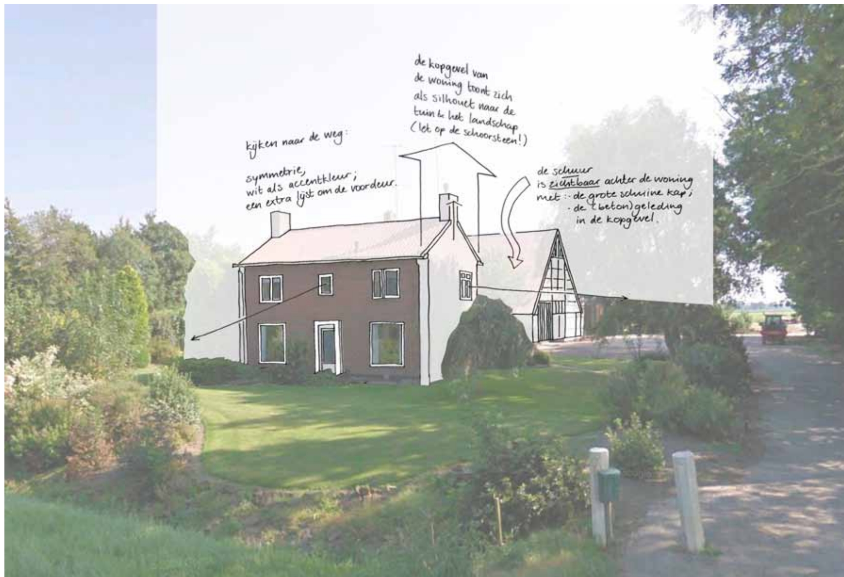
Kenmerkende bouwkundige elementen van het woonhuis
