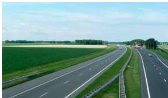
Dwars door de kamerstructuur
